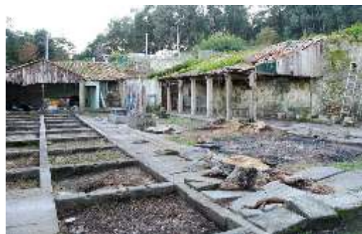
Estado antigo da instalación
