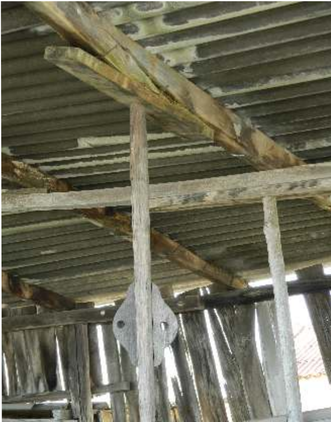
Un remo apuntalando o teito
